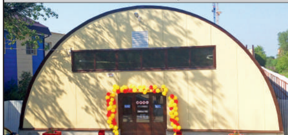
СКЛАДСКИЕ И ПРОИЗВОДСТВЕННЫЕ ПОМЕЩЕНИЯ
